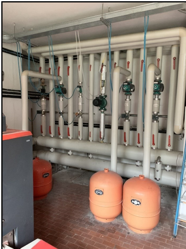
Immagine collettore di riscaldamento ambienti suddivisi a zone ed elettropompe di circolazione a velocità fissa
