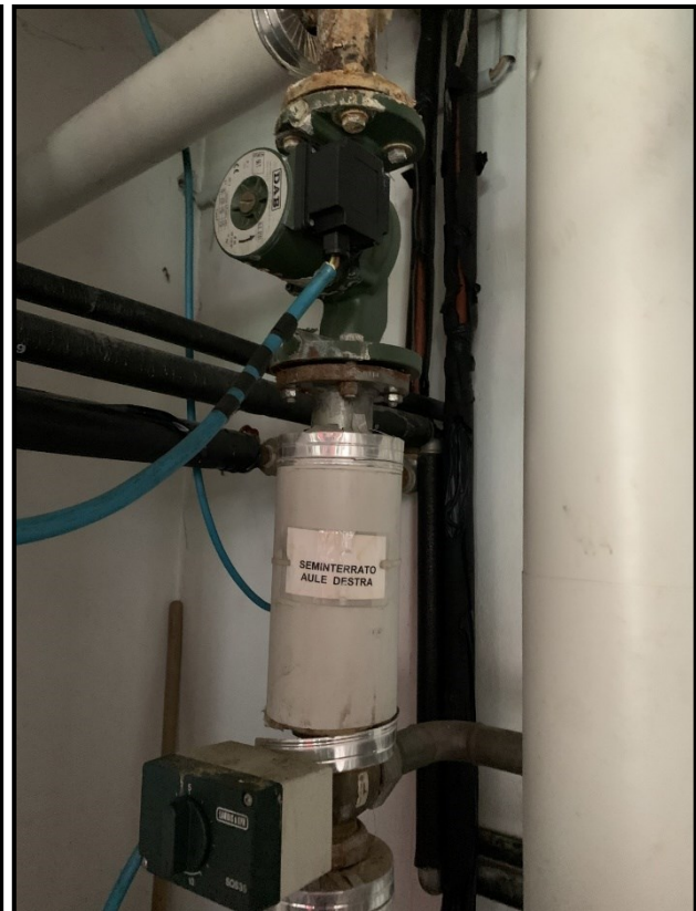
Immagine collettore di riscaldamento ambienti suddivisi a zone ed elettropompe di circolazione a velocità fissa
