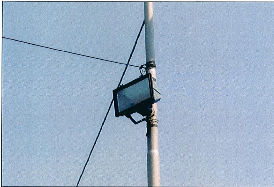
Via Busa: proiettore con lampada ai vapori di sodio ad alta pressione per l'illuminazione della Chiesa della Santissima Trinità.
