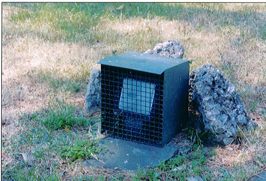
Via Mazzini: proiettore con lampada ai vapori di alogenuri metallici per l'illuminazione del monumento ai Caduti.
