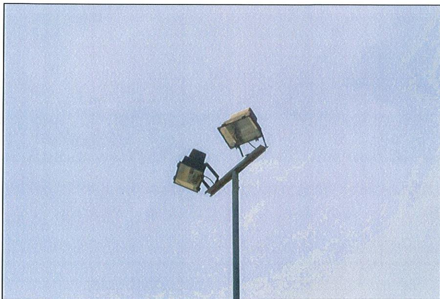
Via Ribolla: proiettore con lampada ai vapori di sodio ad alta pressione per l'illuminazione del parcheggio.
