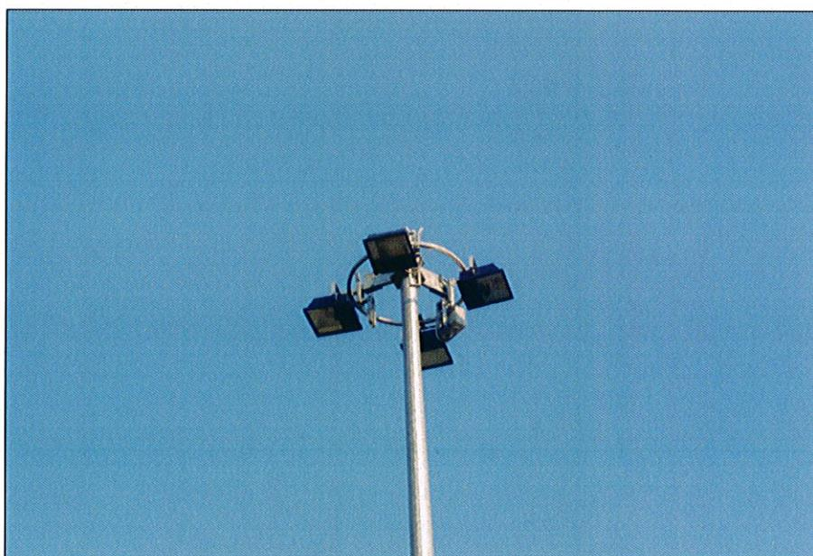
Viale Piave: torre faro con proiettori con lampade ai vapori di sodio ad alta pressione.
