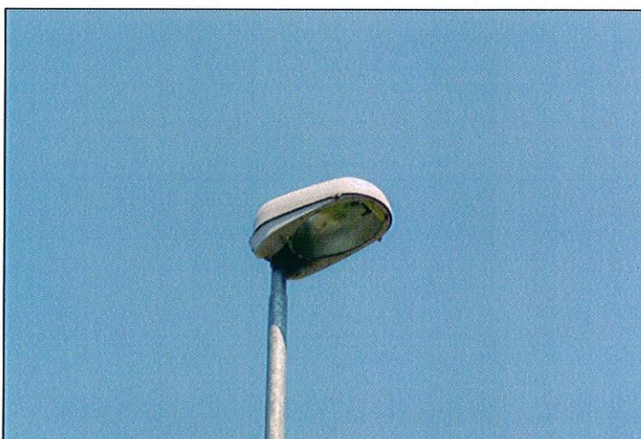
Via Grumello: esempio di apparecchio con vetro piano conforme alla L.R. 38/2004.
