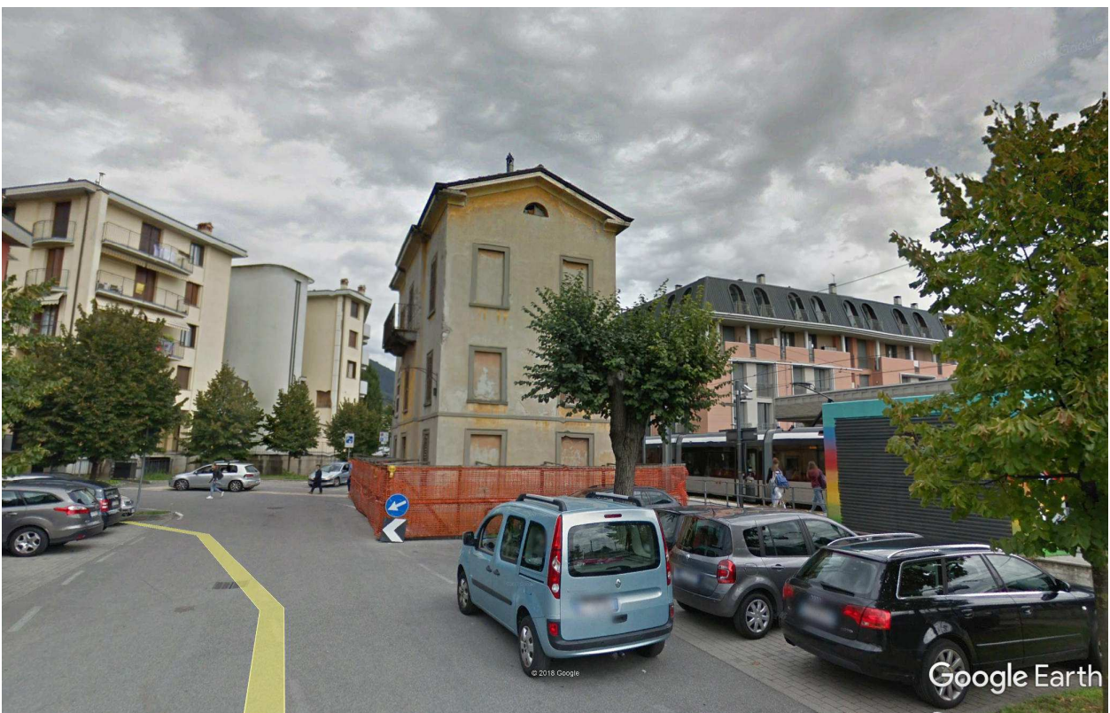
foto 2 – vista da Sud
