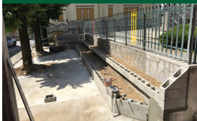
Lavori di messa in sicurezza degli edifici scolastici
