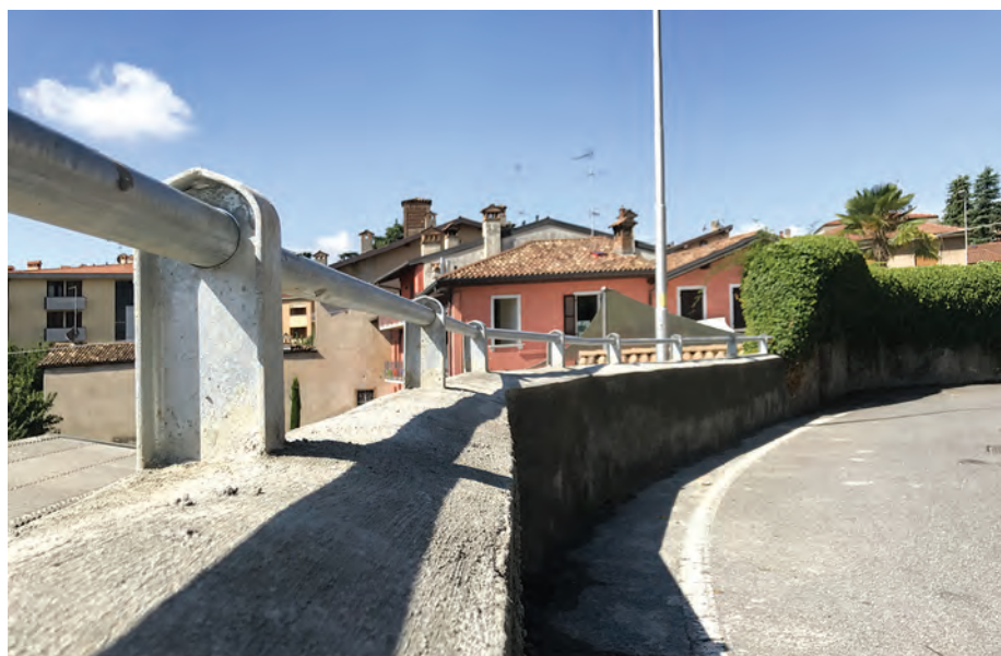
Muro/parapetto di via XXV Aprile
