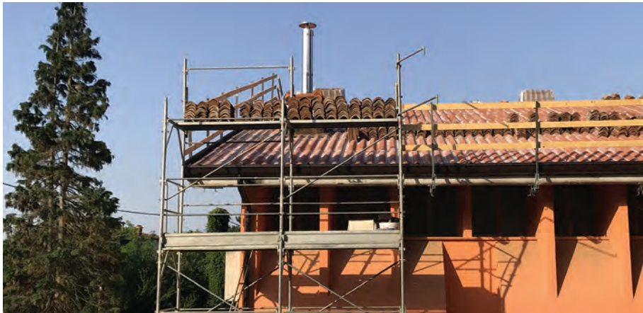
Lavori di manutenzione straordinaria al tetto delle Elementari di Nese
