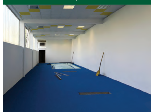
Ristrutturazione della pista di atletica indoor
